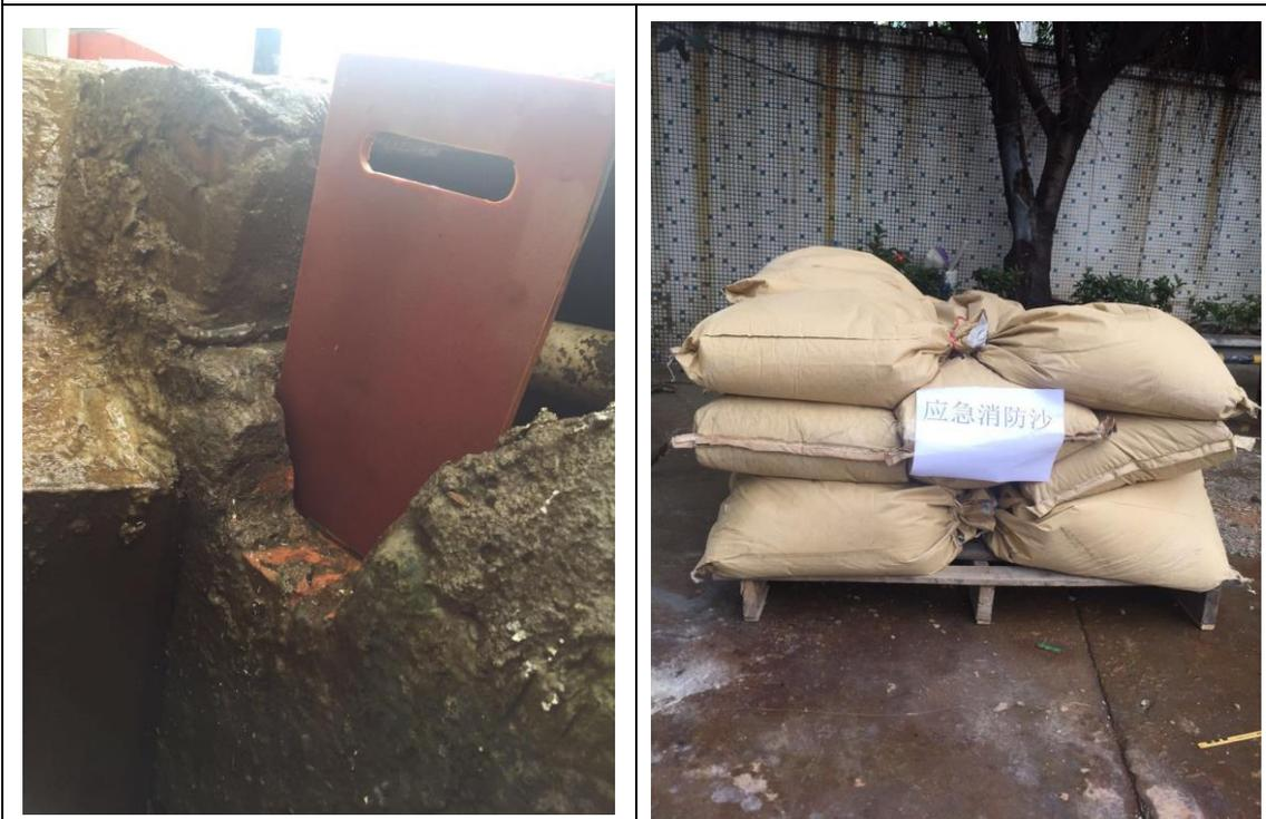
附图 2：厂区雨水沟出水总排口设置闸门
