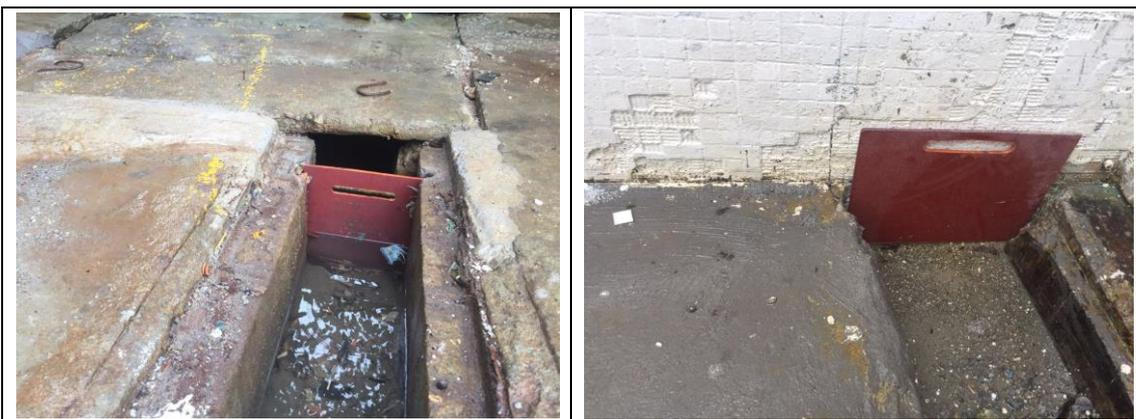
附图 1：应急池进水口设置闸门
